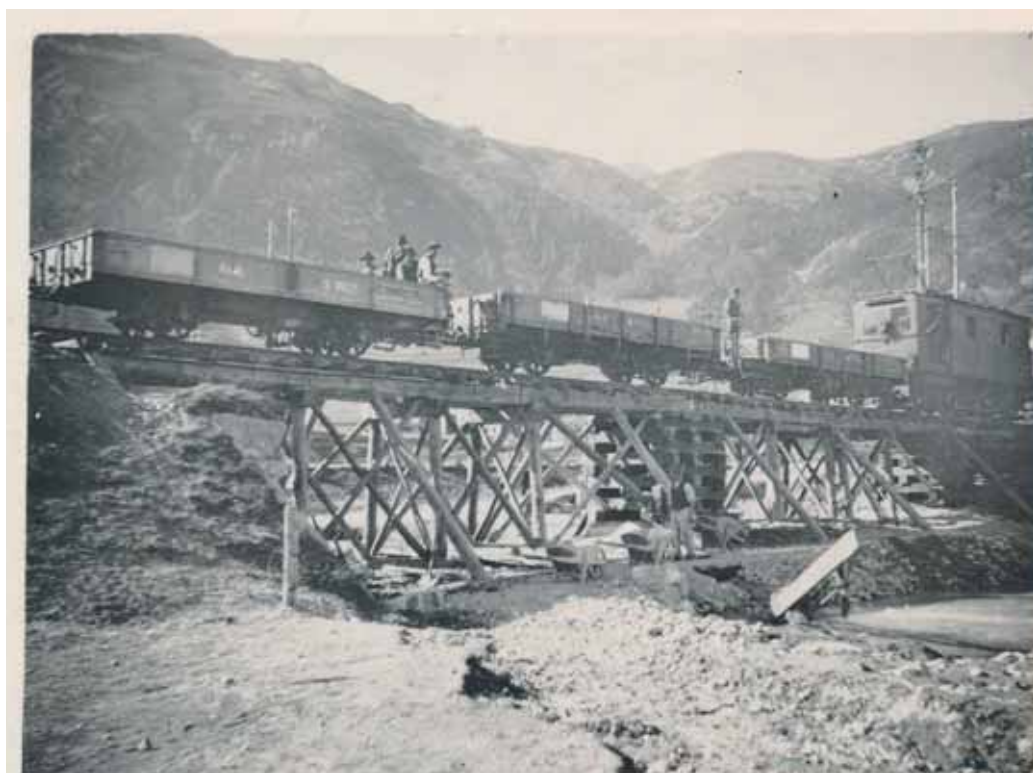
Tar l'ovazun desastrus dal 1927 causet l'En üna ruottadüra da bod 40 meters tres la scarpada dal binari (purtret sur). La Retica stuvet uschè svelt cu pussibel fabricher üna punt provisorica per garantir il traffic feroviel traunter Samedan e Puntraschigna (purtrets imez e suot).
