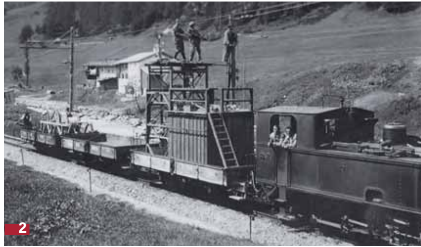
1 Viel Muskelkraft war gefragt beim Aufstellen der Holzmasten für die Fahrleitung unterhalb von Davos Platz anlässlich der Elektrifikation anno 1919.
